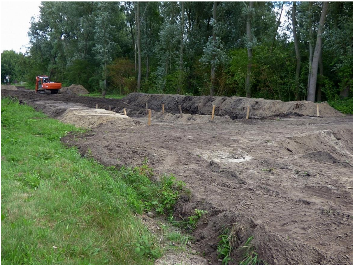
Aanleg van een parcours voor een Mud Run in Groengebied Amstelland 14 augustus 2014
