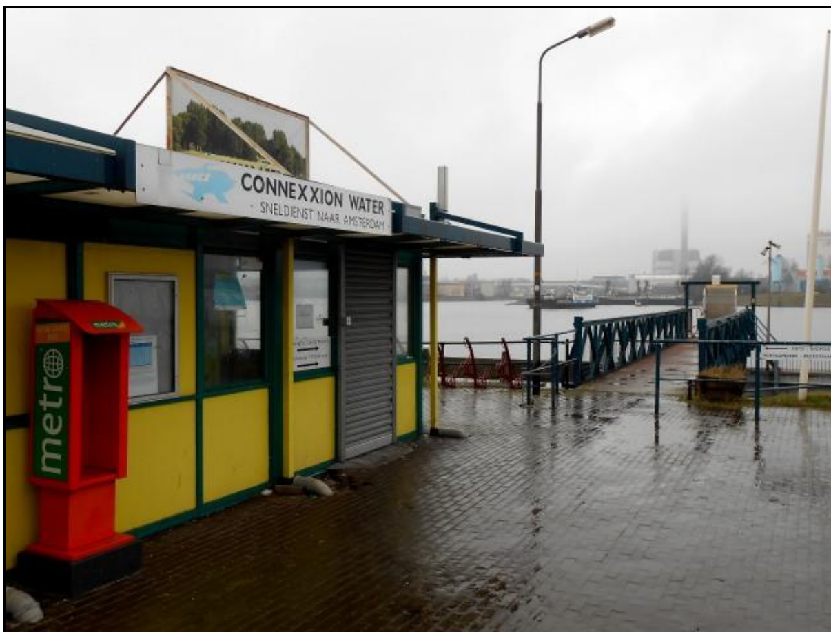
Het kantoorgebouw van Connexxion en de steiger aan het Pontplein in IJmuiden zijn nog volledig intact. De foto is genomen op 20 februari 2015.
